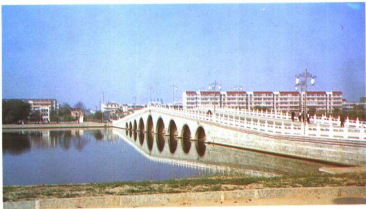
玉带浮水化为桥
