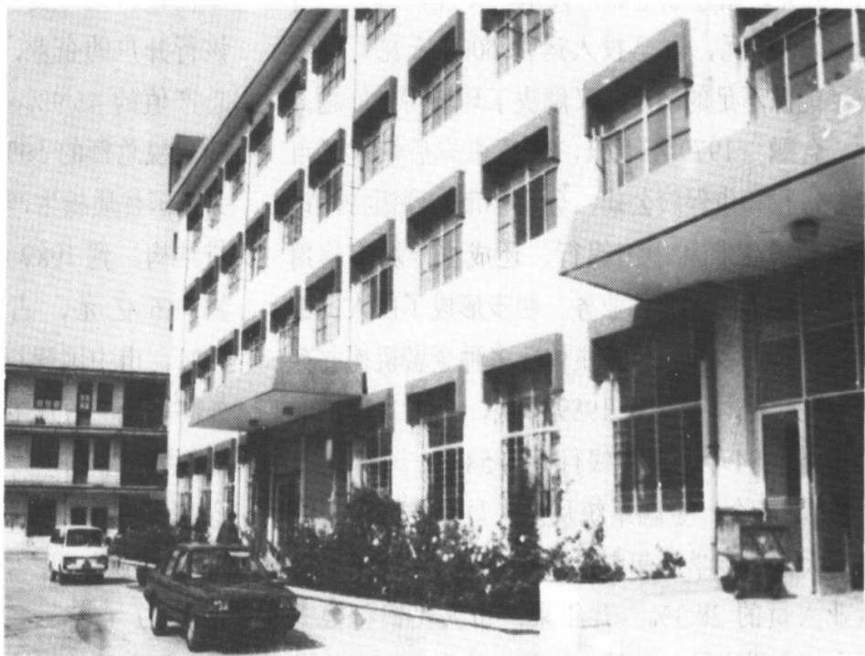
中国工商银行临清支行营业楼
