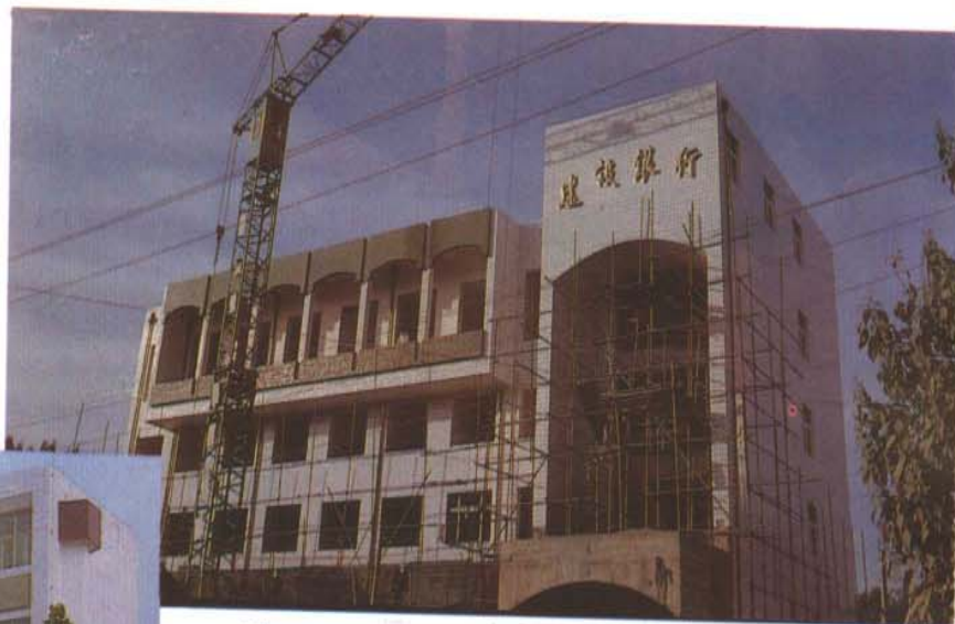
聊城地區建築工程公司第三工程處承建的臨清市建設銀行大樓
