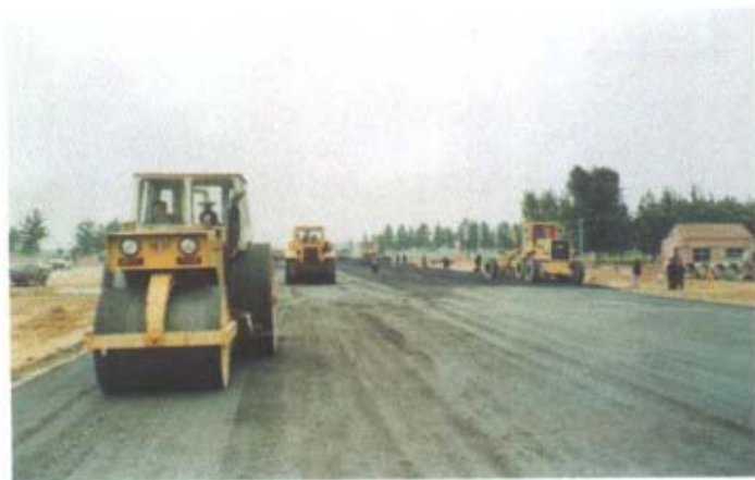
路面基层施工现场一角
