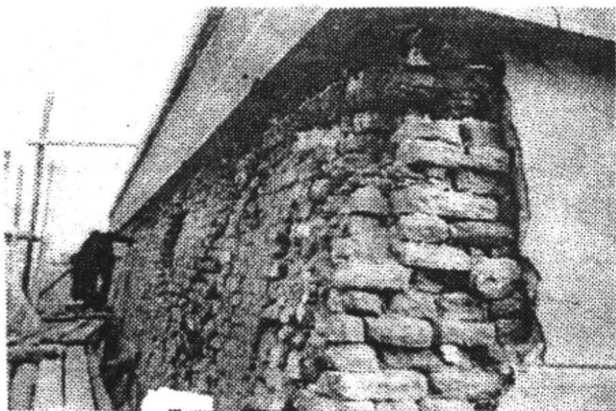
图3 铲除水泥后的大墙
