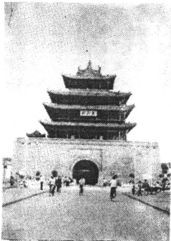
图 4 光岳楼修复后全貌
